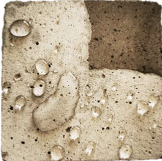
Sicorol F:llä käsitelty betonikuutio. Vesi helmeilee käsitellyllä alueella, eikä imeydy pintaan.
