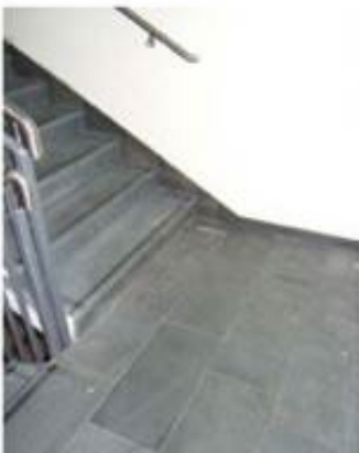
Foto 14. Detalj skiferfiser på trapp og sokkellist
