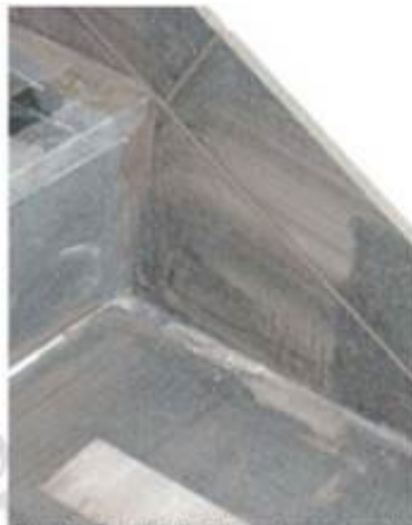
Foto 15. Detalj skiferfiser på trapp og sokkellist
